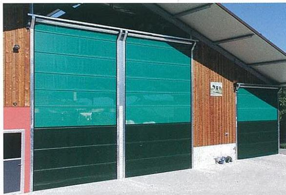
Die robusten Materialien behalten über Jahre ihre Festigkeit und lassen sich leicht und schnell reinigen. Kombinationssysteme aus winddichten und windbrechenden Folien garantieren eine kontinuierliche Frischluftzufuhr auch in windexponierten Lagen.
