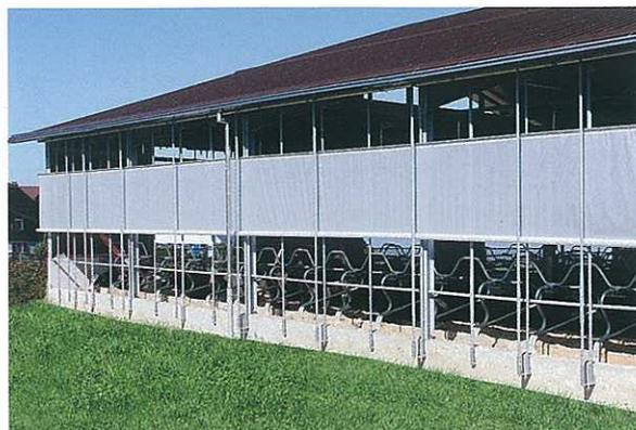
Winddichte Folien in Kombination mit einer bedienungsfreundlichen elektrischen oberen und unteren Aufrollung bieten das ganze Jahr über perfekten Windschutz bei optimierbarer Lüftung.
