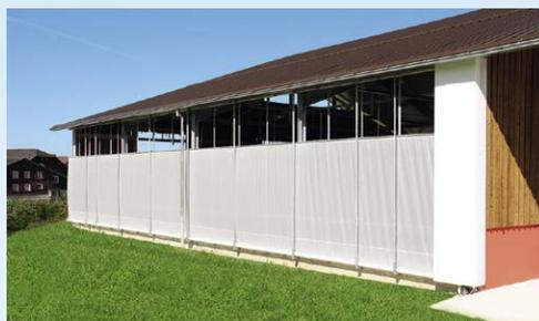
System C: von unten nach oben und von oben nach unten öffnend
