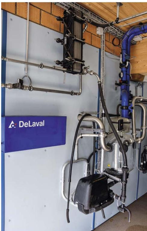
Die kompakte Einrichtung im Milchzimmer spart Platz und ist trotzdem gut zugänglich und übersichtlich. Durch den oben montierten Plattenkühler gelangt die Milch vorgekühlt in den Milchtank, was besonders energieeffizient und nachhaltig ist.
