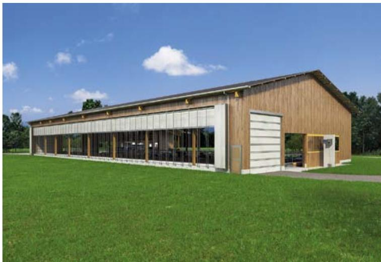
Dank des lichtdurchlässigen Rollvorhangs kann der Stall mit Tageslicht und Luft durchflutet werden. Bei der Futterdurchfahrt werden Rolltore eingesetzt.
