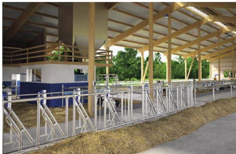
Auf der Bühne über dem Melkroboter ist ein Zweikammer-Silo für 9 Tonnen Kraftfutter eingebaut. Das Silo wird direkt mit dem Fütterungssystem verbunden. Eine zusätzliche Fütterungsschnecke ist nicht mehr nötig.
