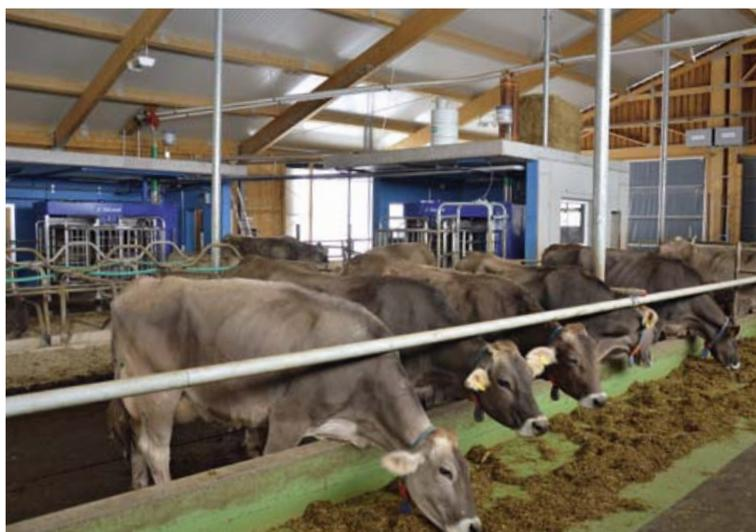
Das Herzstück des Stalls sind die beiden DeLaval Melkroboter. Über ein Separierungstor können zu überwachende Kühe einfach von der Gruppe getrennt werden.
