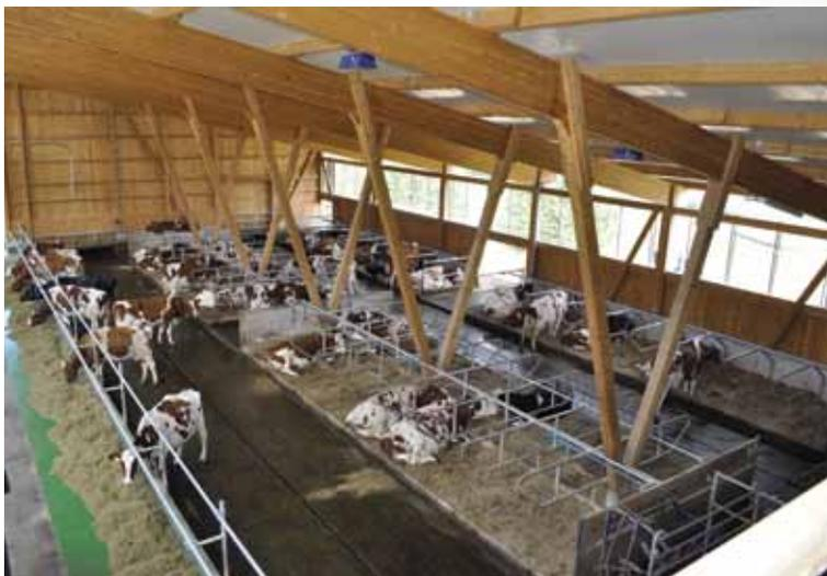
Sicht von oben in den Neubau. Der 3-reihige Stall mit den Liegeboxen Thurgi und den zwei Entmistungsschieberbahnen.
