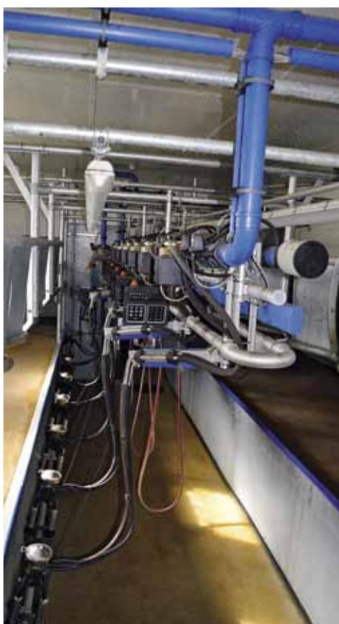
Der Melkplatzcontroller MPC680 und das Milchmengenmessgerät MM15 ist die richtige Kombination für Familie Bulliard.
