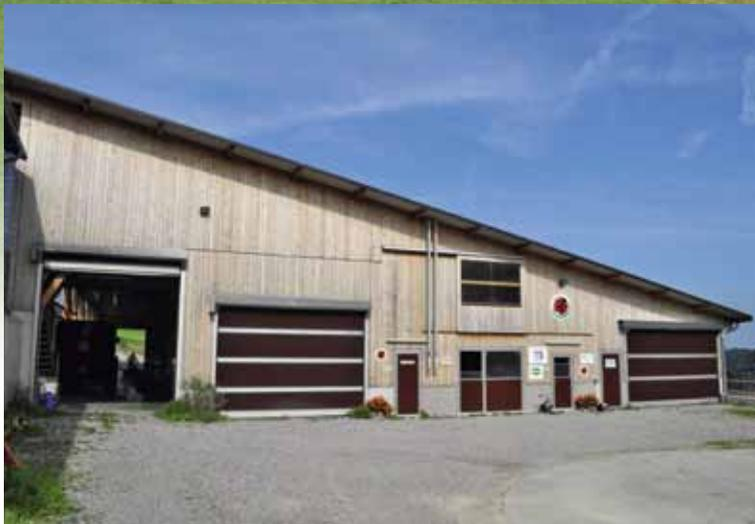
Das Pultdach überzeugt durch seine Einfachheit und der Luftführung. Sämtliche Bereiche wie Kälberstall und Fressplatz sind maschinell befahrbar. Alle Türen und Tore wurden von DeLaval montiert.
