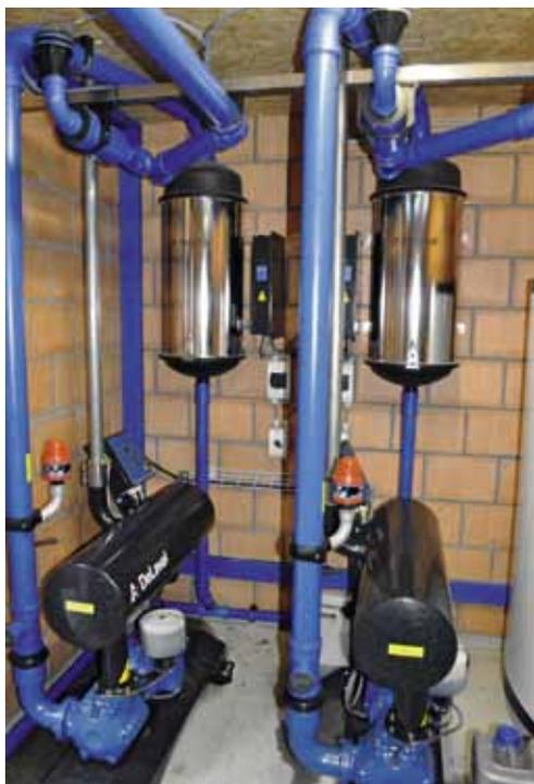
Frequenzgesteuerte Vakuumpumpen sorgen für ein effizientes und schonendes Melken.
