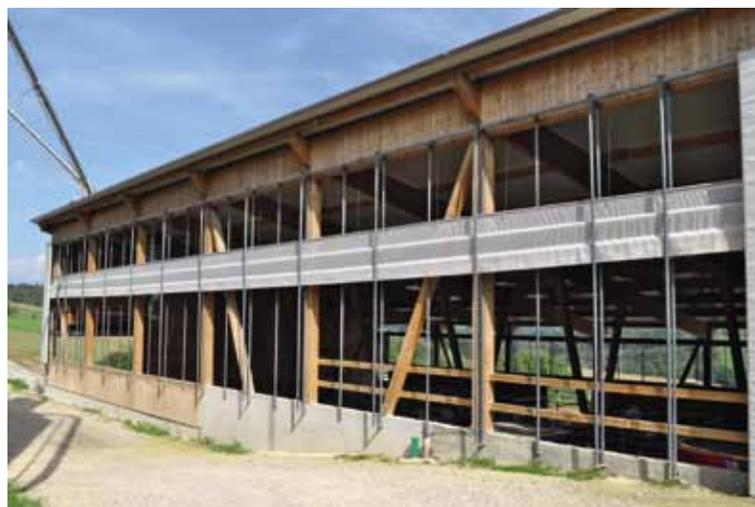
Gute Luft und viel Licht sind jederzeit im Stall vorhanden. Mit dem Windschutzsystem Curtain von DeLaval können sehr grosse Flächen geöffnet und geschlossen werden. Das Licht kommt durch die beidseitig zu öffnenden, transparenten Aussenwände.
