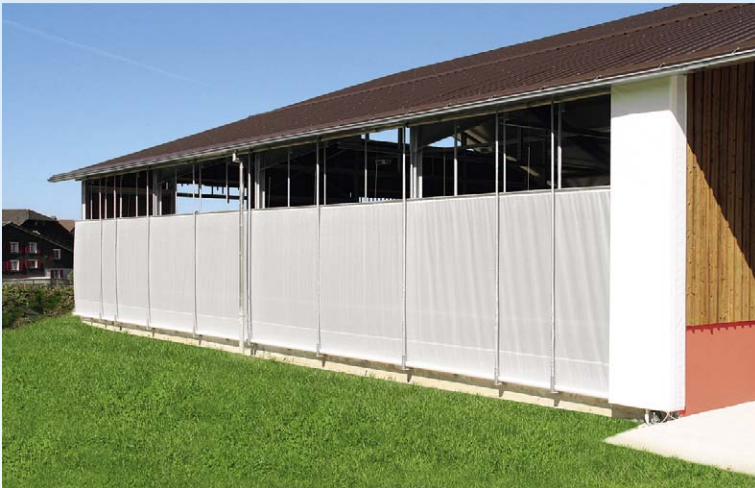
System C: von unten nach oben und von oben nach unten öffnend
