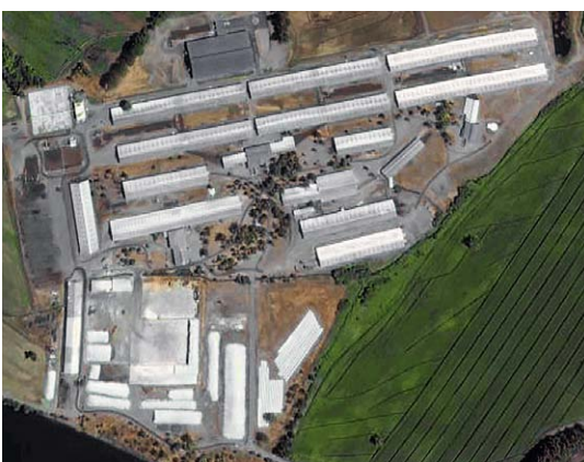
Ansicht von oben: Der Betrieb Fundo El Risquillo in Chile
