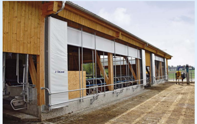
System A: von unten nach oben öffnend
