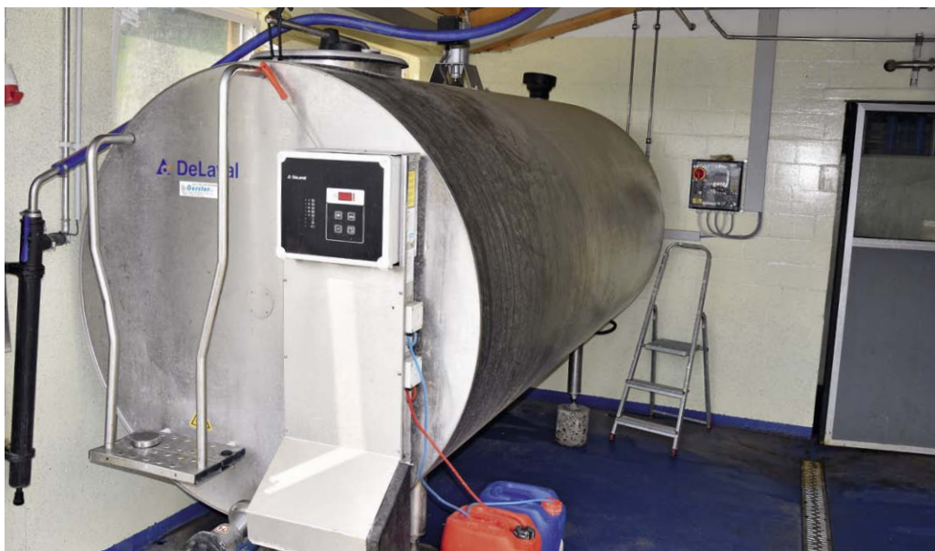
Der Milchtank DXCR 4'000 l sorgt für die optimale Lagerung der Milch. Der Abnehmer der Milch ist die Firma Schwyzer Milchhuus AG in Schwyz.
