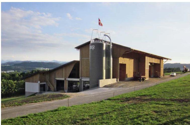
Die neue Scheune ist in den Hang eingebettet.
