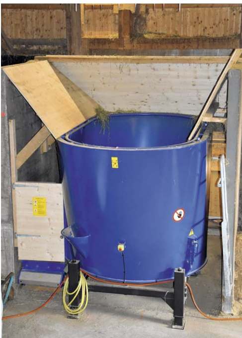
Der 10 m 3 Mischer fand gut im bestehenden Gebäude Platz. Mineralstoffe oder Kraftfutter können auf bequemer Höhe durch den Einfülltrichter zugegeben werden.
