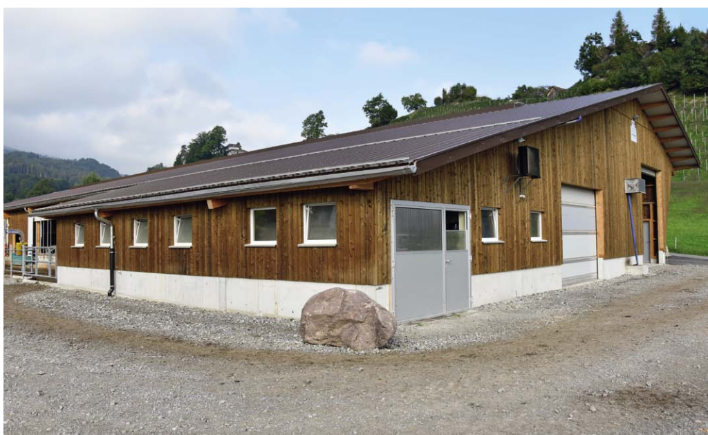
Sämtliche Fenster, Türen und Tore sowie Windschutzsysteme wurden von DeLaval geliefert.
