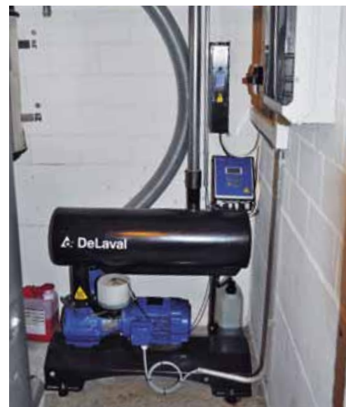
Die frequenzgesteuerte Vakuumpumpe ist ein wichtiger Bestandteil der Melkanlage. Die geringe Lärmentwicklung und der äusserst sparsame Energieverbrauch sind die wichtigsten Eigenschaften der Pumpe.
