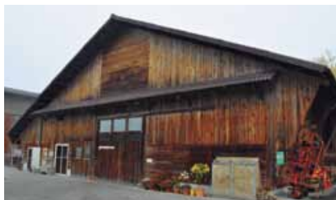
Nicht nur in Neubauten wird in ein automatisches Melksystem investiert. Zunehmend werden VMS Melkroboter auch in umgebauten Ställen installiert.
